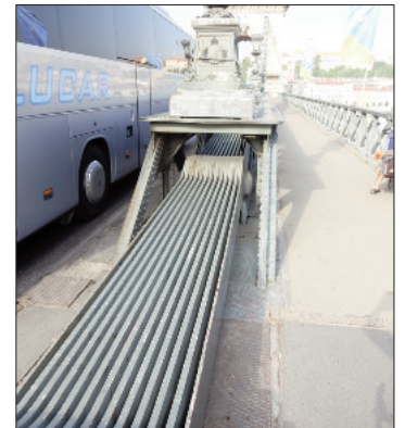
Budapest. Les éléments porteurs de ce pont sont en forme de chaîne de vélo.
