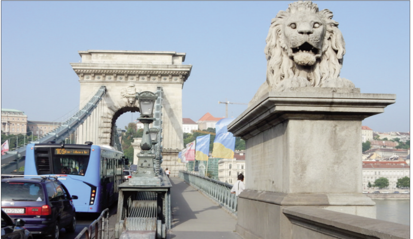
Budapest. Les éléments porteurs de ce pont sont en forme de chaîne de vélo.
